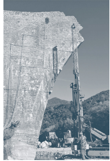
Αναστήλωση γεφύρου Πλάκας
